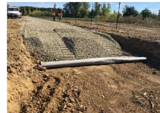
Figure 70 : Exemple de réalisation de voie d'accès interne
