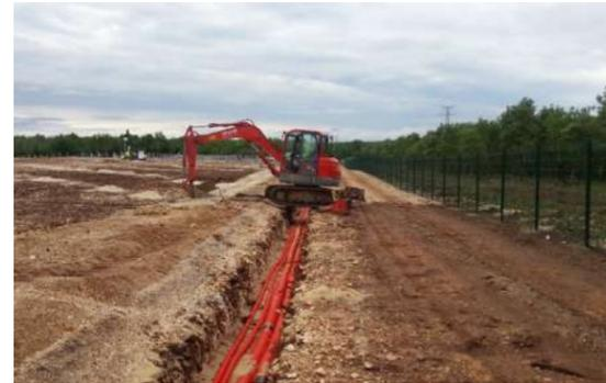
Figure 71 : Exemple d'enfouissement de câbles électriques
